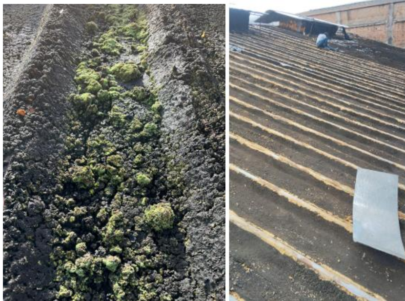
Imagen 1: Retiro de material Biológico de la Cubierta del Teatro Tolima
