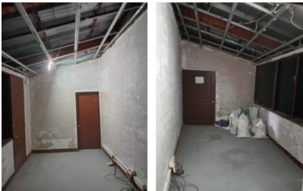
Imagen 7. Desmonte de estructura de cielo raso zona izquierda de Platea
