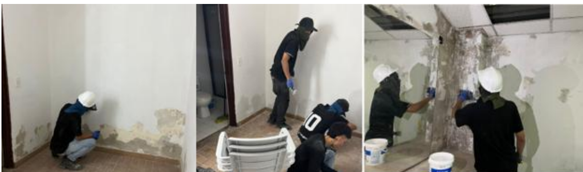
Imagen 4. aplicación de estuco y lijada en los camerinos 5 y 6 del Teatro Tolima
