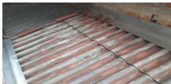
Imagen 8. Desmonte de teja de barro sobre puesta sobre la cubierta.
