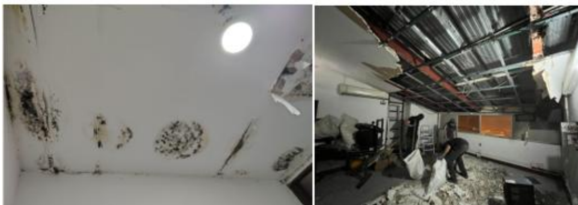
Imagen 5. Desmonte y retiro de cielo raso Zona Platea
