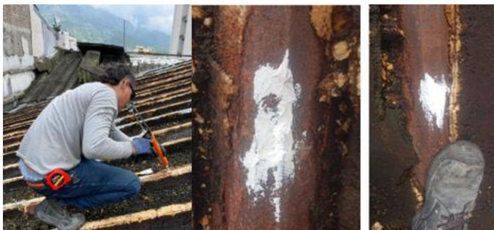
Imagen 3. Aplicación de Siza Flex en las grietas de la cubierta
